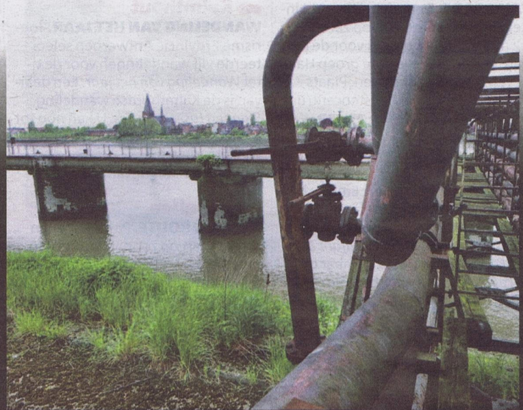
De historische betonnen pier uit 1904 wordt nog steeds gebruikt.
